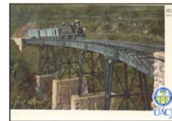
F. C. VERACRUZ: Viaducto de Wimar (pocomotora de madera que conduce cuatro vagones)
