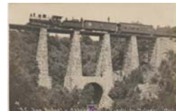
Ferrocarril de San Rafael y Atlixco: Puente de Metepac. (México). Postal Fotográfica
